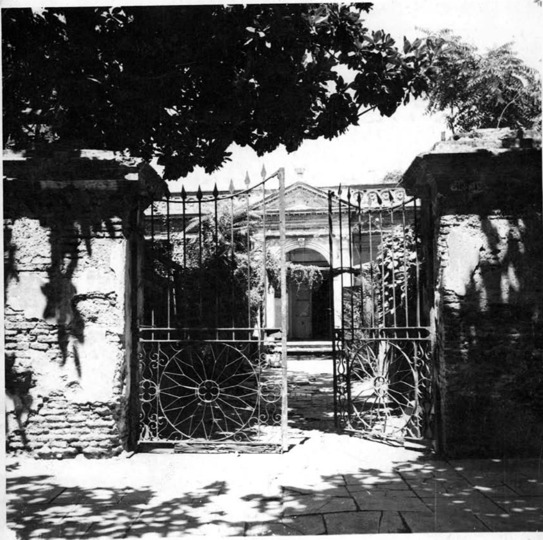
Fachada del Hospital de Niños de la calle Victoria, hoy Hipólito Yrigoyen 3420
