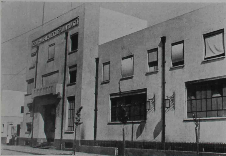
Figura 1.—Aspecto exterior de la Central de Leche "Santiago".
